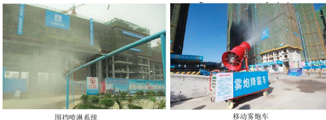
图 8.5-1 施工区喷淋系统示意图
