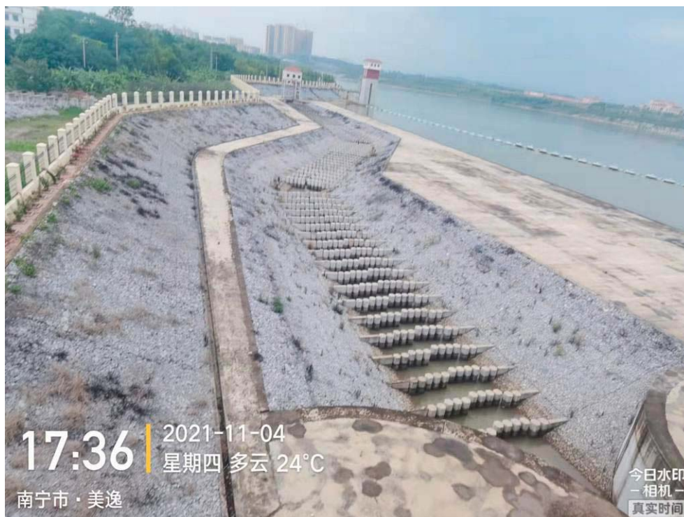
图 8.3.4-3 邕宁枢纽过鱼设施
