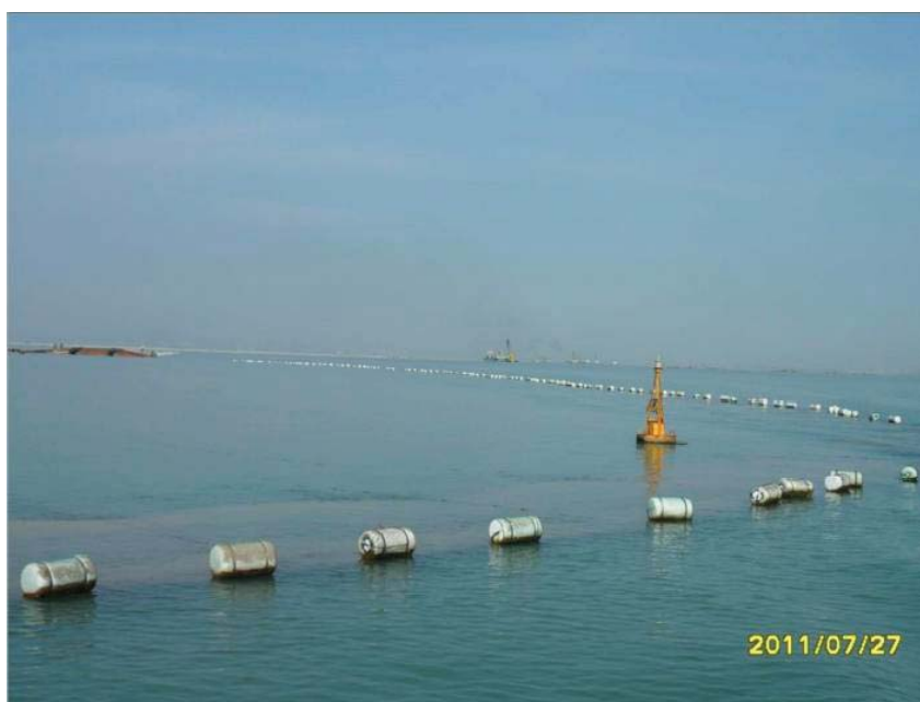
图 10.6.2-2 防污帘使用现状
