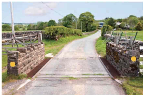
图 5-1 桥头附着的反射器设置示例
