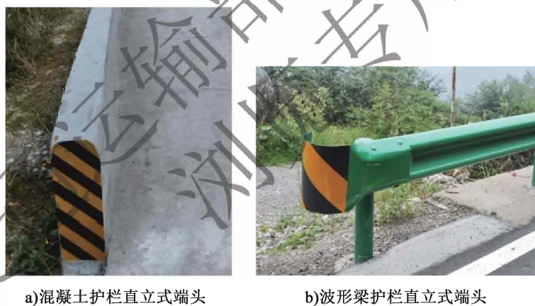
图 6-1 护栏直立式端头
