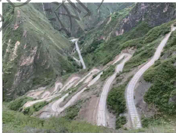
图 3-2 不需要在每个急弯处设置急弯路标志的示例
