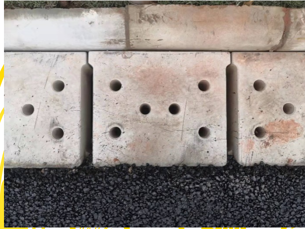
图2 设置快速排水通道的预制盖板
