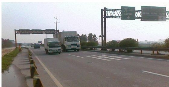
图B.4 G15 沈海高速公路广东佛开段改扩建工程施工作业区运行状况
