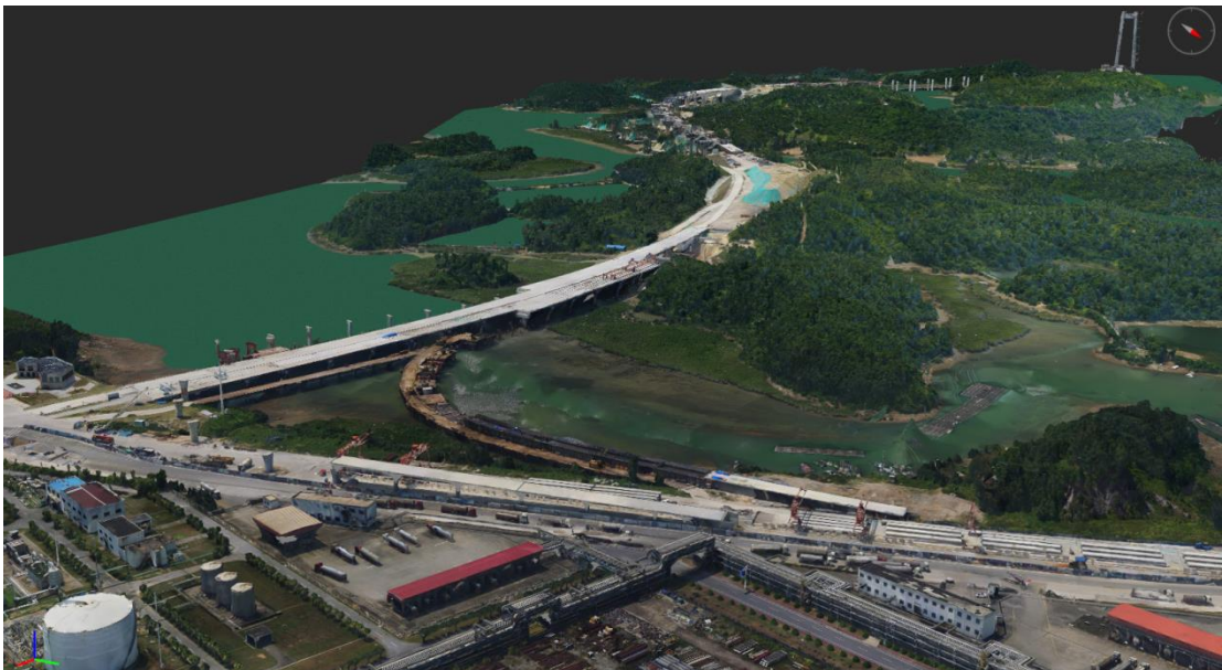
图 13 龙门大桥定期航拍进度管理
