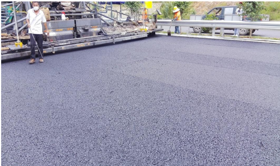
图 8 橡胶沥青混合料摊铺
