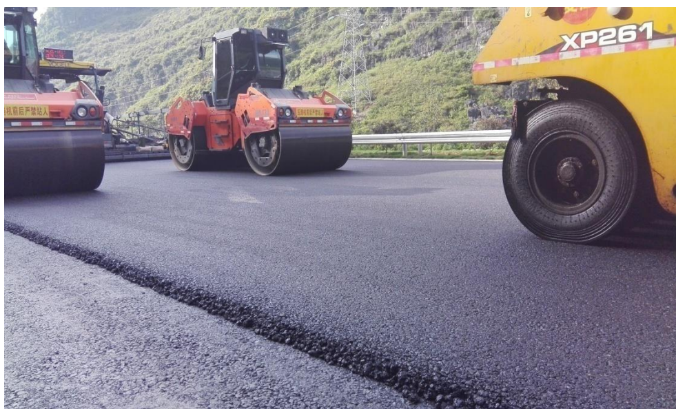
图9 橡胶沥青混合料碾压
