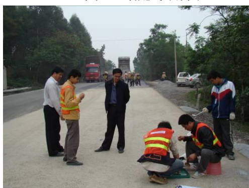
图8 级配碎石基层压实度检测
