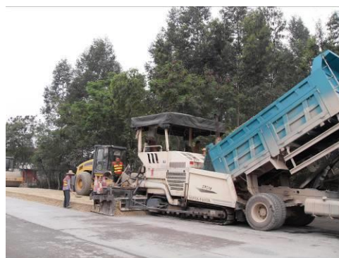
图7 级配碎石摊铺与碾压
