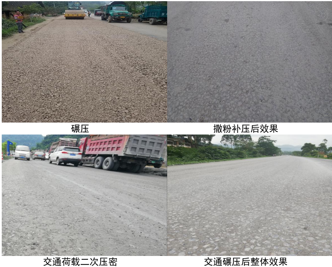
图 1 大粒径级配碎石施工工艺
