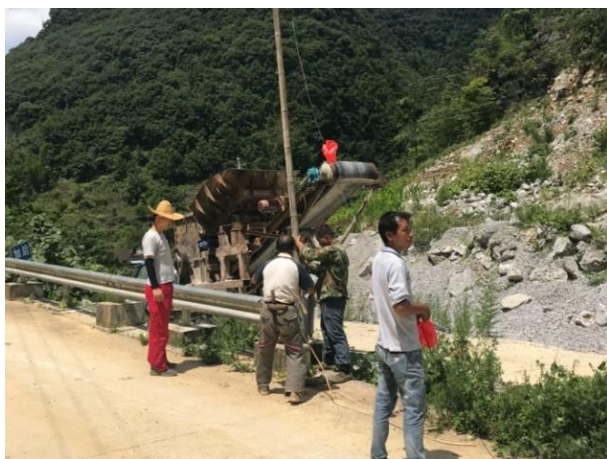
图 34 路口架设电缆
