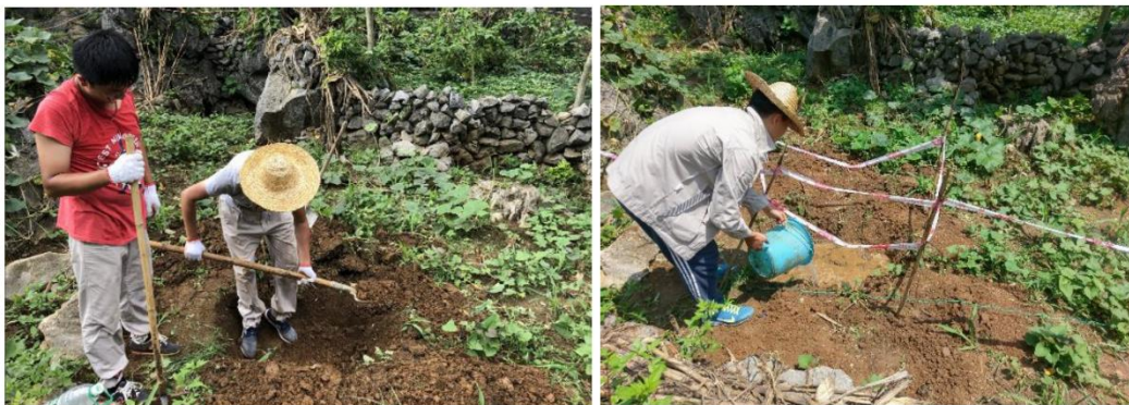
图 17 发射端电极坑挖设及电极埋设
