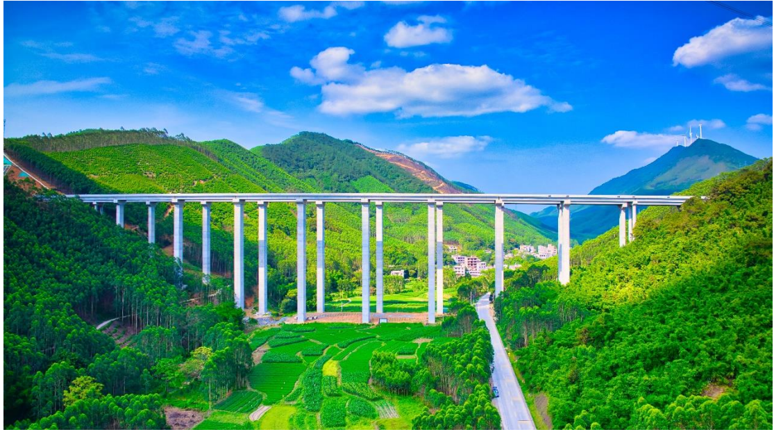
筋竹头大桥实景图（二）
