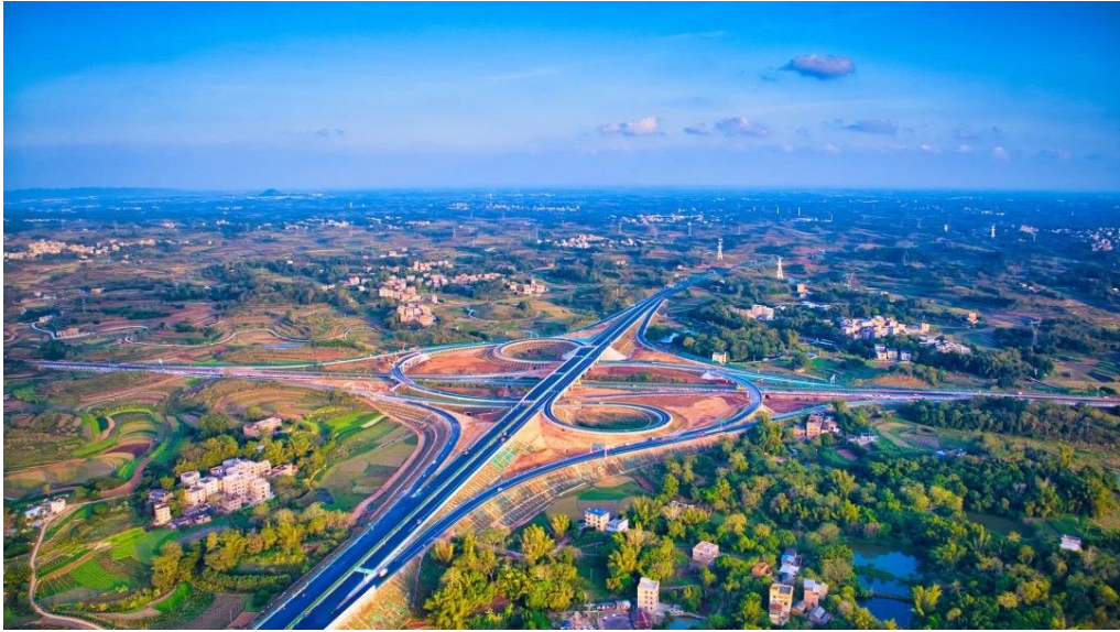
六冲枢纽互通俯视图
