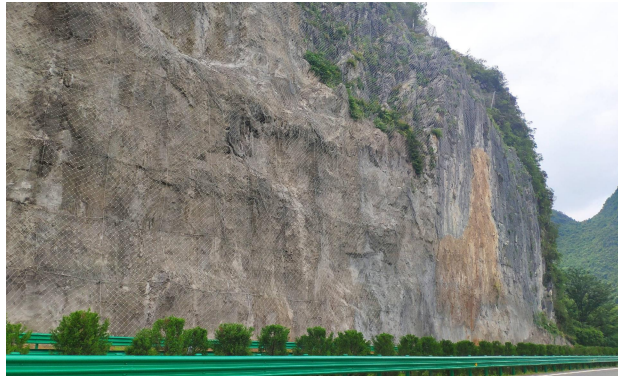
图 10 都巴路某灰岩边坡
