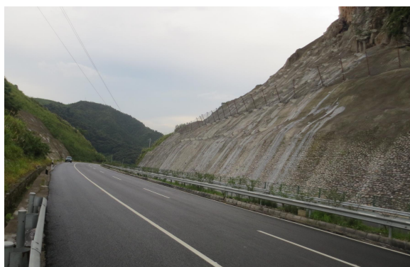
图 9 钟马路某灰岩边坡
