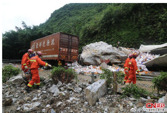
图5 都南路 K1848 危岩崩塌
